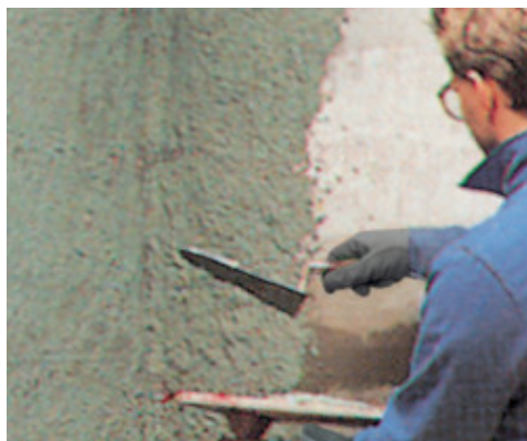
Rinzafo adesivo additivato con Planicrete
