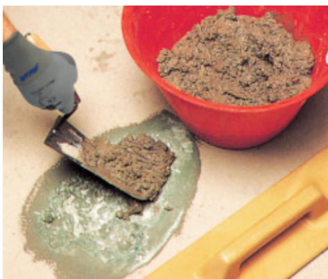
Rappezzo di pavimento: applicazione malta
