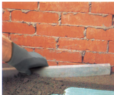
Applicazione di massetto cementizio aderente additivato con Planicrete
