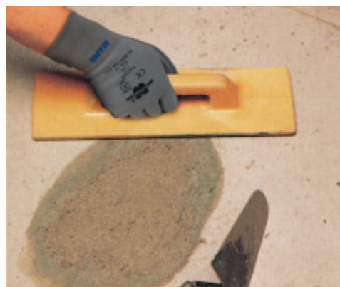
Rappezzo di pavimento: lisciatura finale
