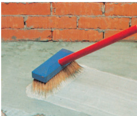
Applicazione di boiacca cementizia additivata con Planicrete
